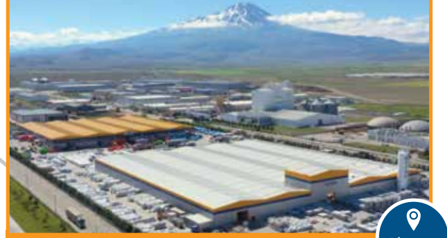
PVC-U ve PP-R Sistem Üretim Tesisi
